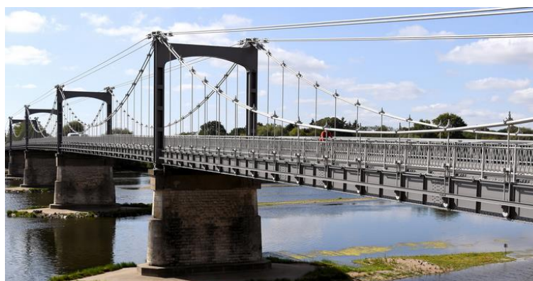
Figure 59 : Pont reliant Châteauneuf-sur-Loire à Sigloy
