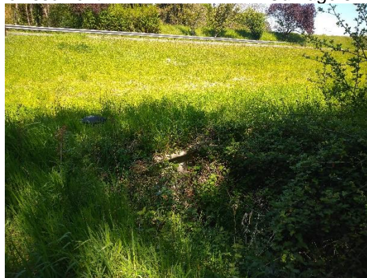
Ouvrage 6 – Aval du projet - Buse DN 500
