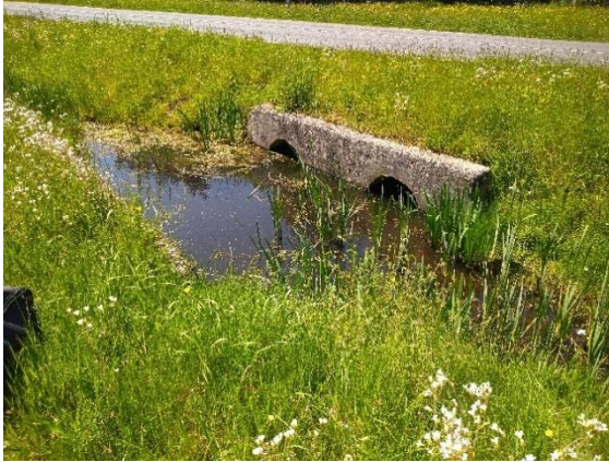
Ouvrage 1 - Franchissement de la RD
